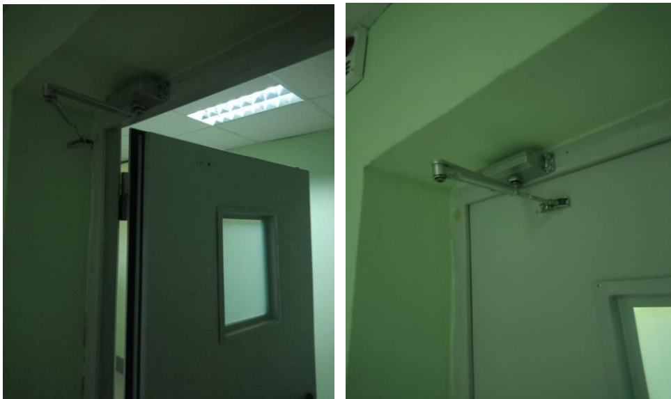
9) 09.08.23 На 22-м этаже у двери лифтового холла - замена неисправного доводчика
